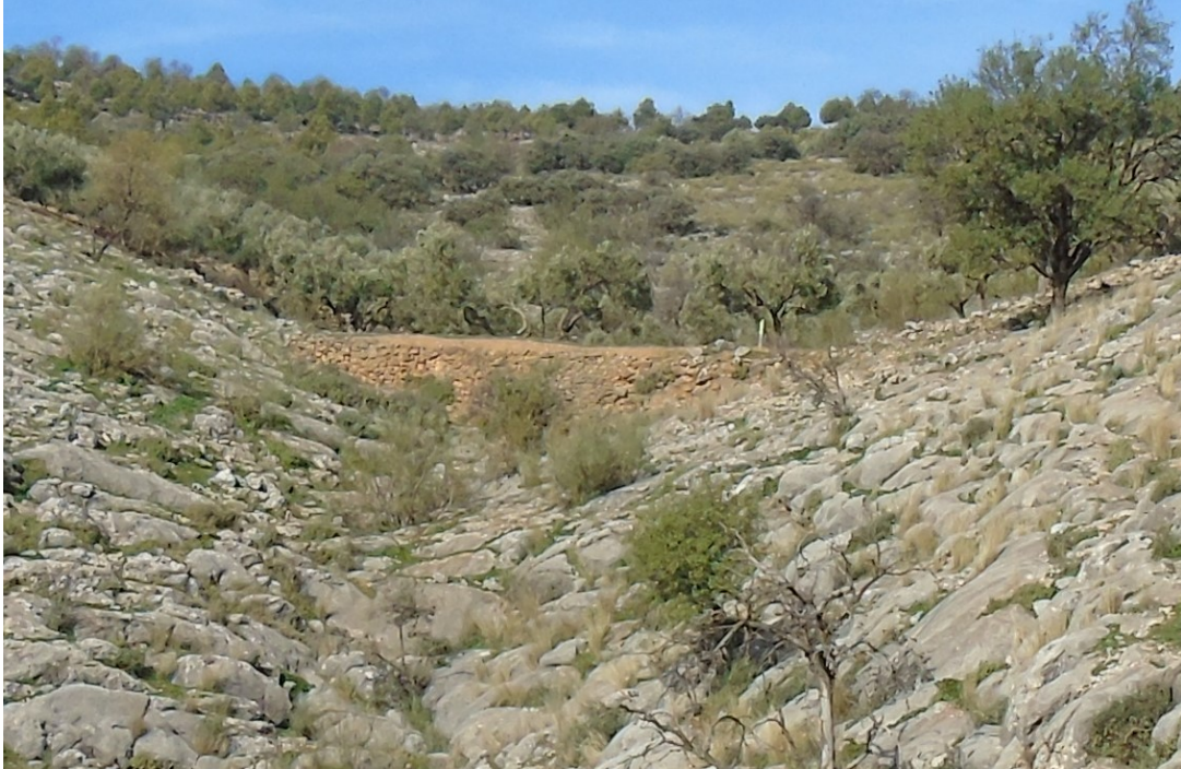
Fotografías: Sendero y albarradas de la Cañada del Santo (09/12/2019).
