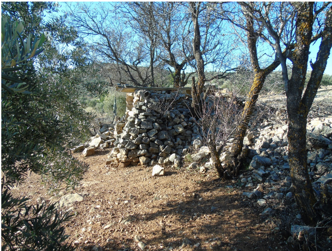
Fotografía: Choza de la Loma de Los Castillejos (07/01/2020)
