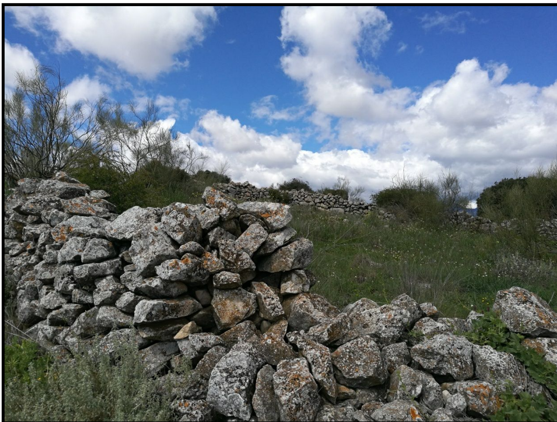
Vista del muro que forma el cerramiento.
