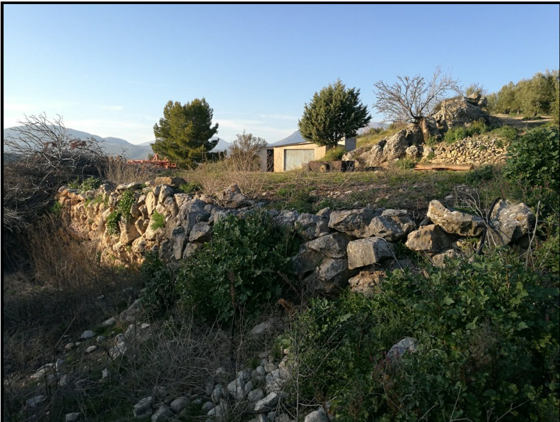
Era 1. Detalle del muro de fijación talud inferior.
