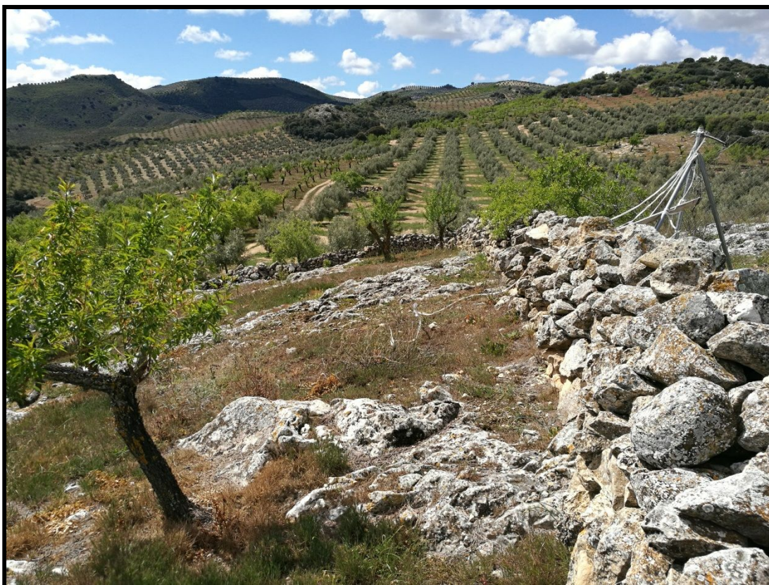
Detalle del muro y cerramiento al lado Oeste.
