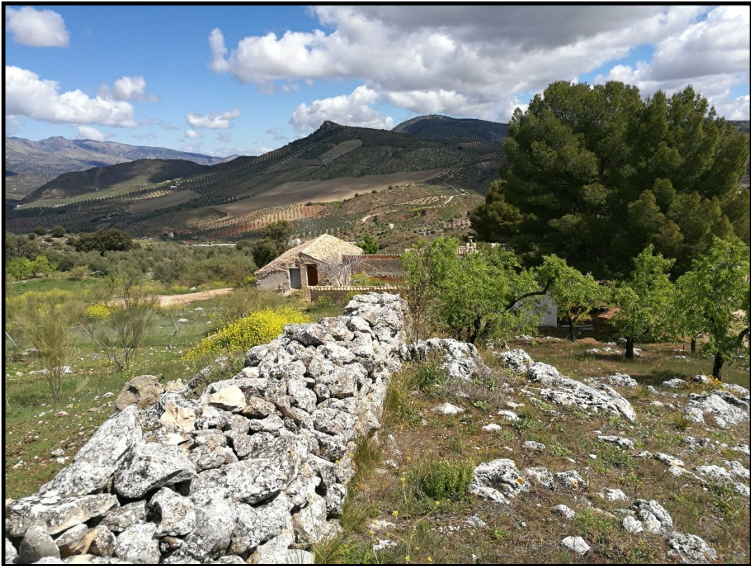
Detalle del muro al lado Este
