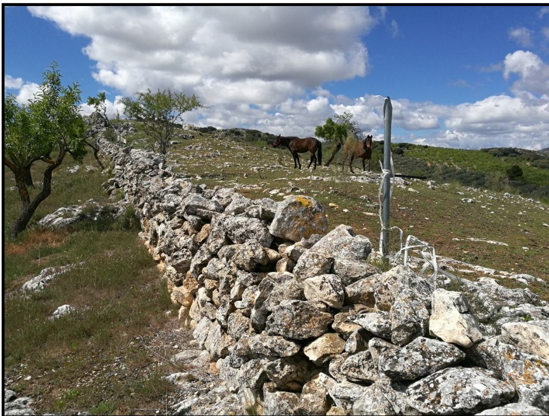
Vista del muro.
