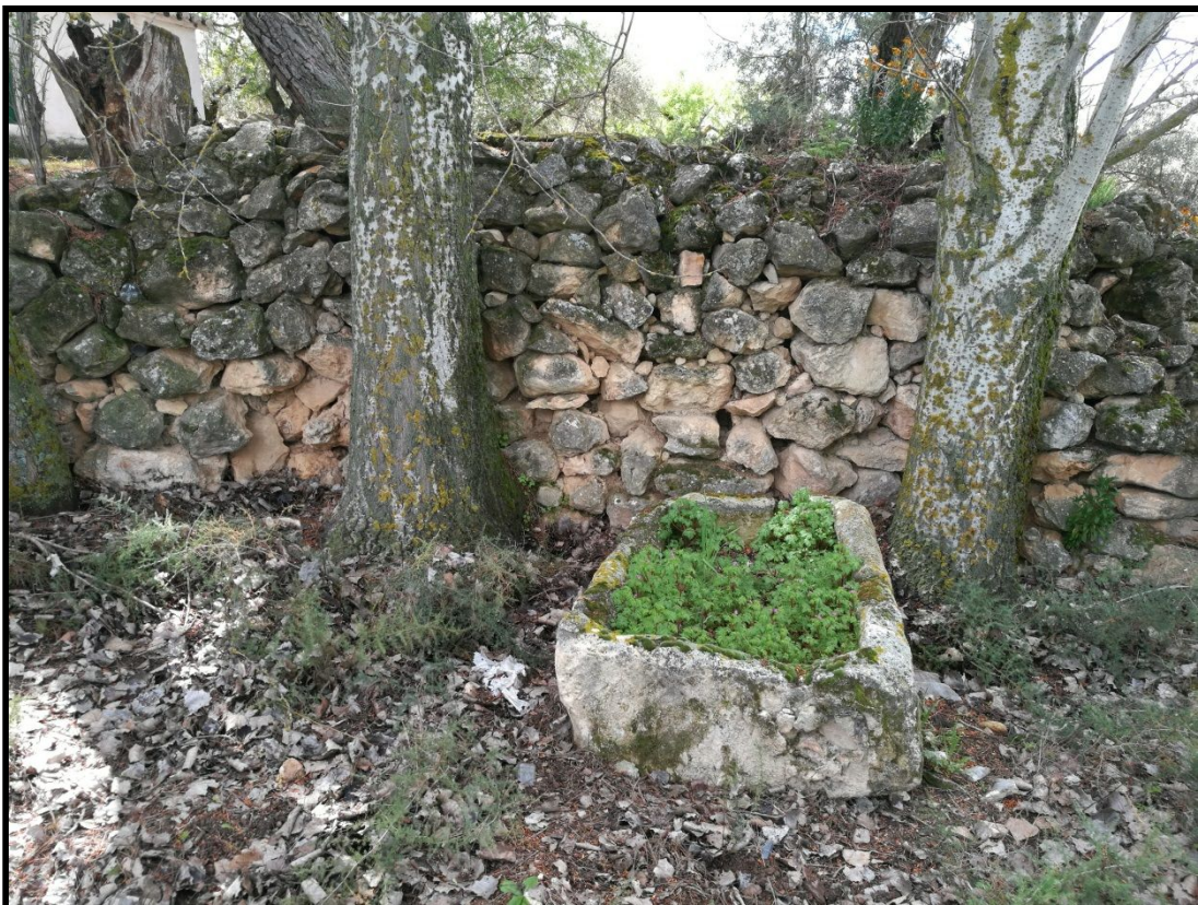
Detalle de la pila 3.
