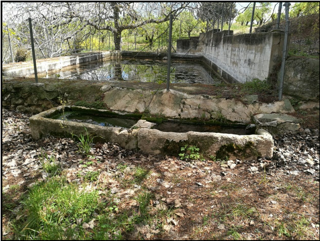
Vista del conjunto de la Fuente del Allozo y pilas 1 y 2.
