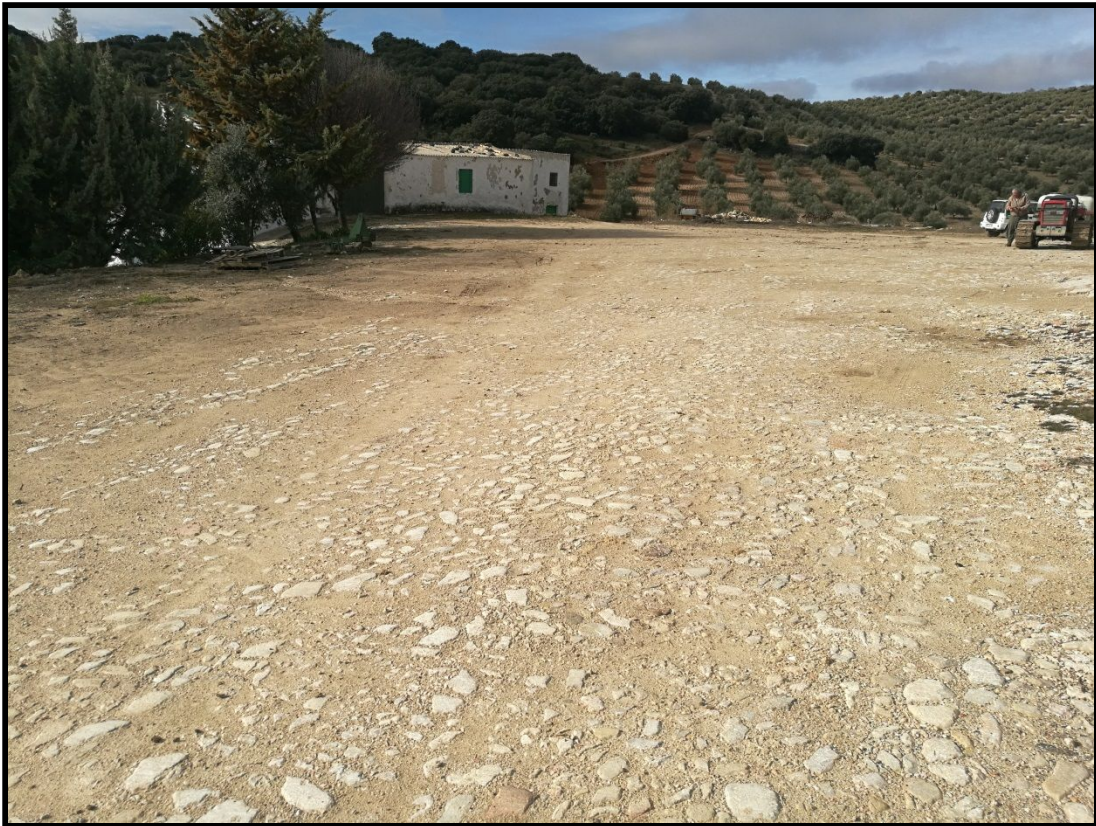
Vista general de la construcción.
