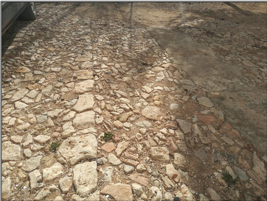
Detalle del empedrado. Se aprecian las líneas maestras.
