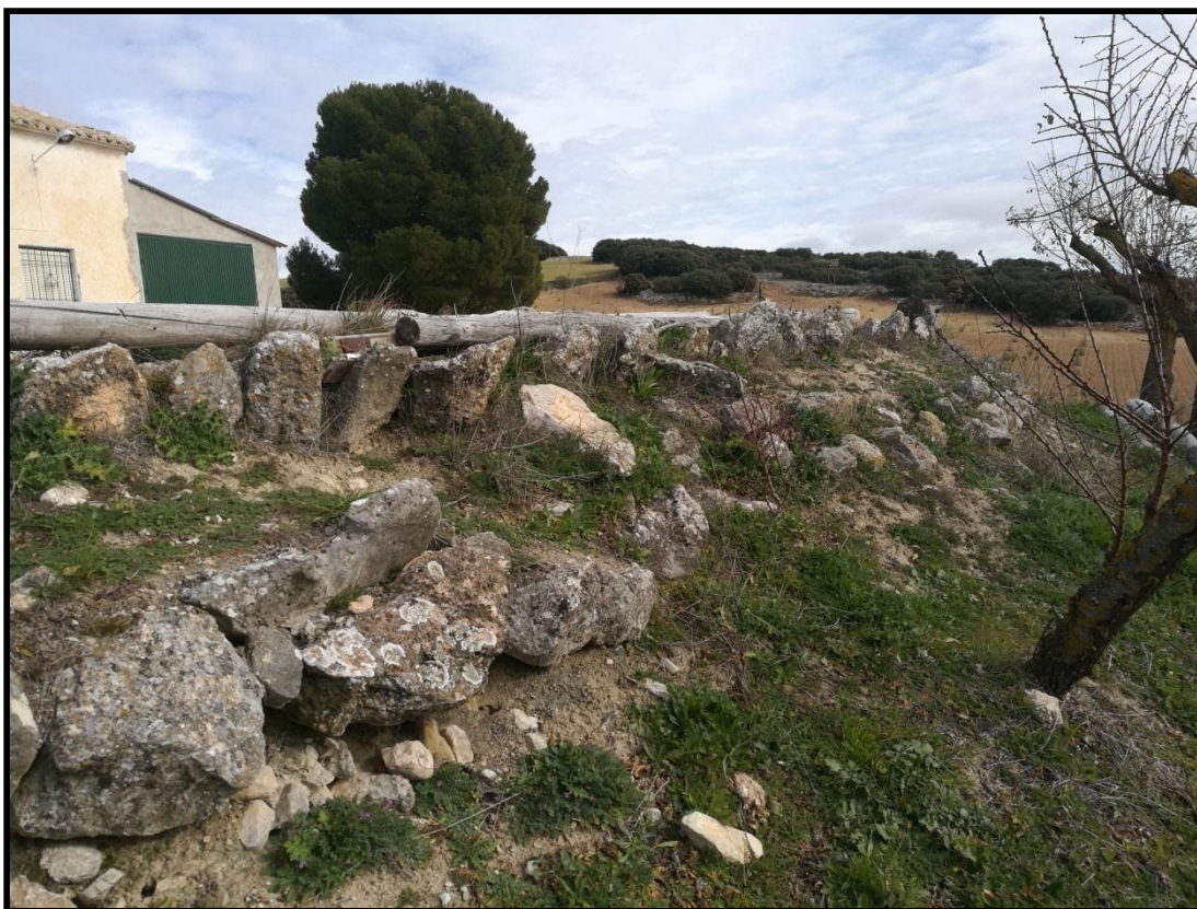
Vista general de la construcción.
