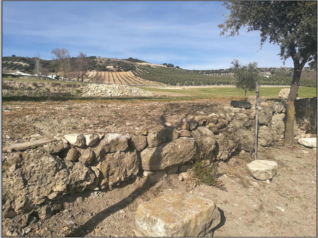
Muro de piedra seca que limita un lado de la era nº 1
