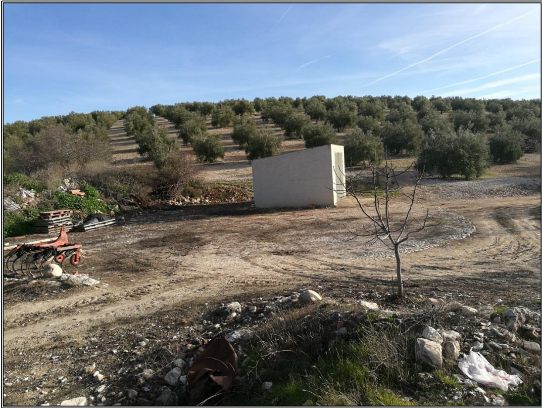
Vista general de la era. Se aprecia la caseta construida encima de la era.
