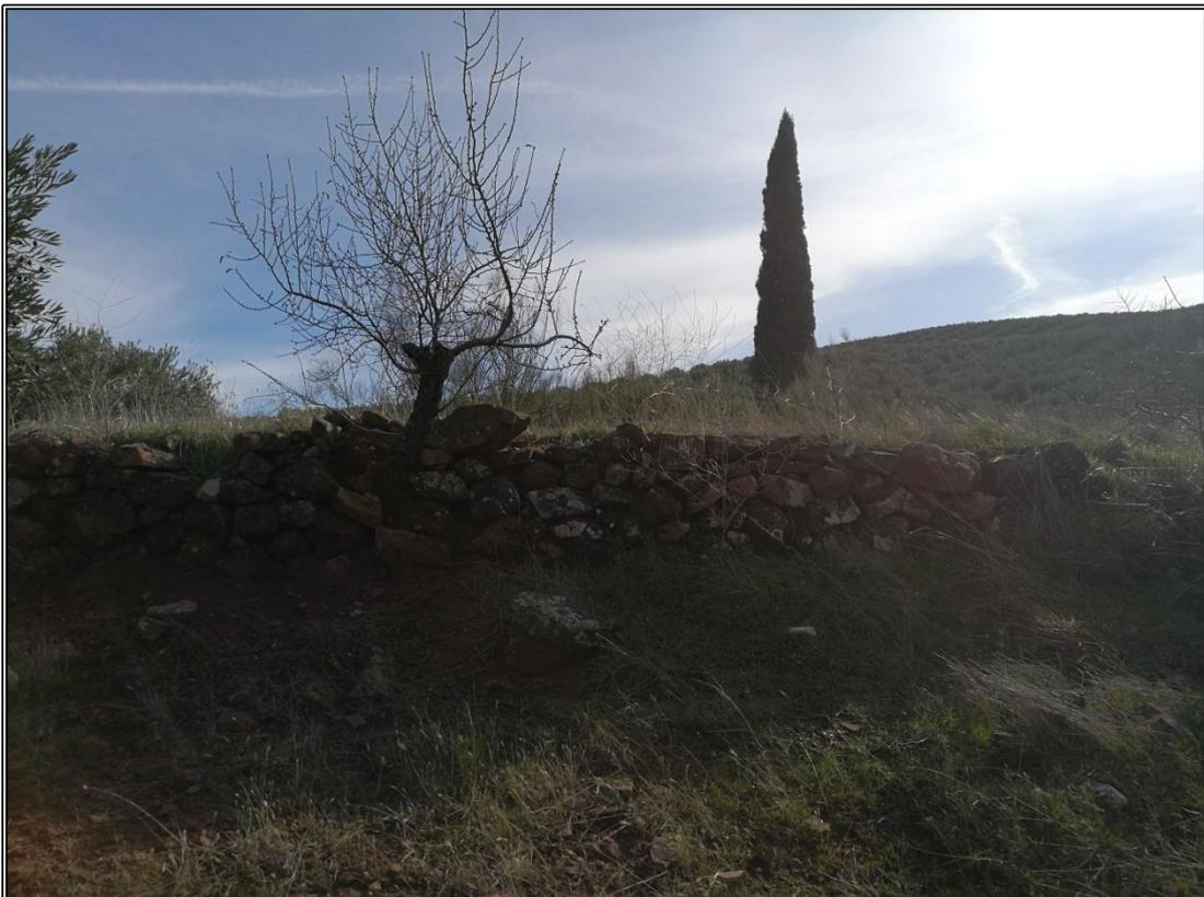
Detalle de la tapia de estabilización del talud inferior de la era.
