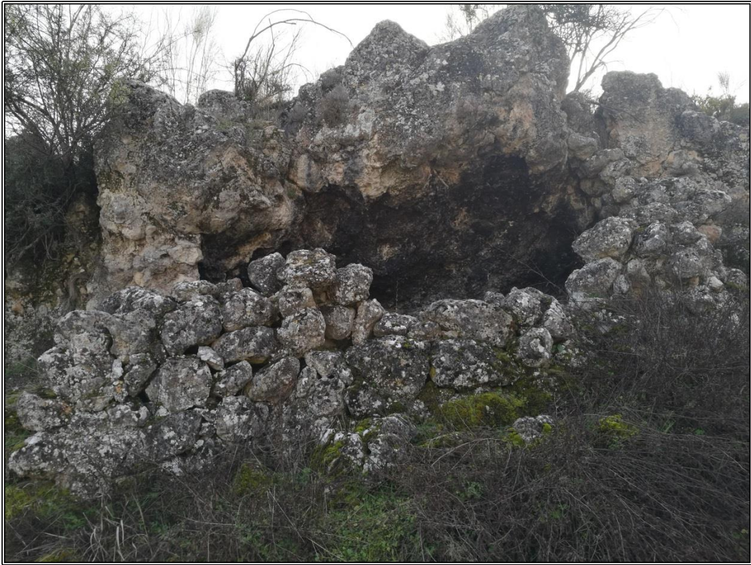
Vista panorámica de la construcción.
