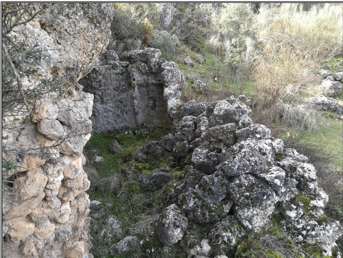
Detalle del muro construido para completar el cerramiento.
