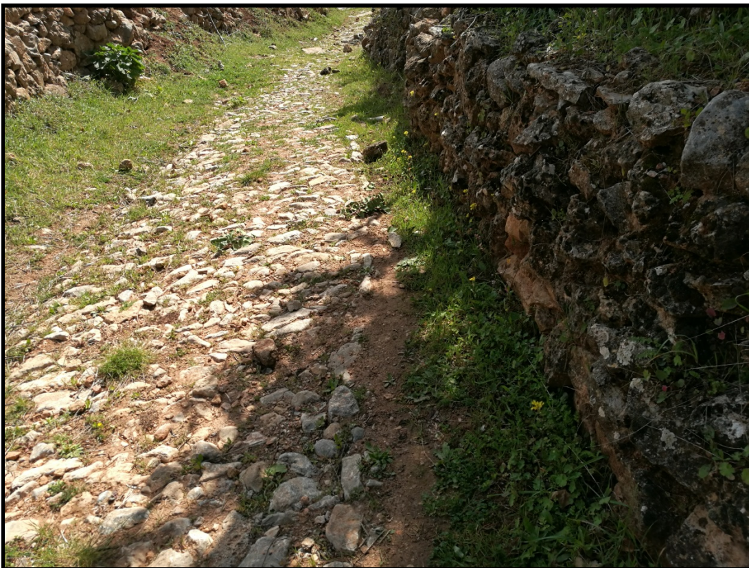
Detalle del empedrado y mampostería de los taludes del callejón.
