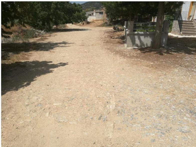
**Conservación:** Mal estado, se encuentra parcialmente aterrado y destruido parcialmente en algunos puntos por la plantación de árboles de sombra, la instalación de un cerramiento de obra y la instalación encima del empedrado de un entresuelo de piedra y hormigón.
