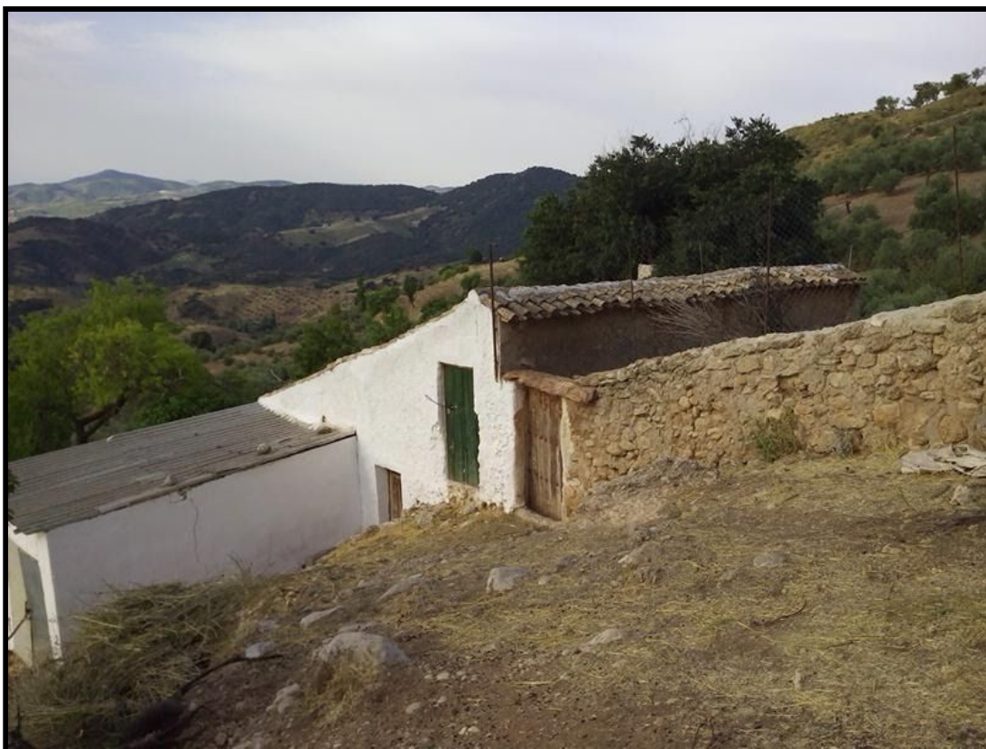
Vista del cortijo ubicado al Sur de la construcción.
