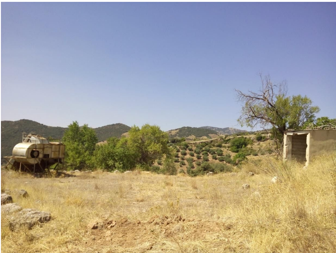
Vista general de la construcción.
