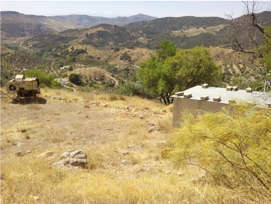
Vista general de la construcción.
