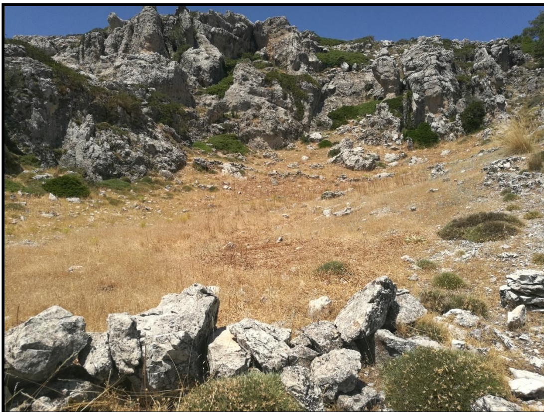
Detalle de los restos del muro que formaba el cerramiento del lado Este y vista del estado actual del lado Norte.
