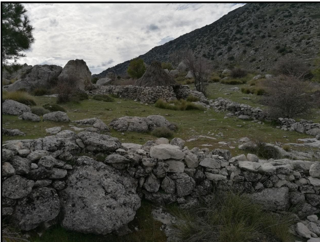
Vista general del conjunto de la construcción.
