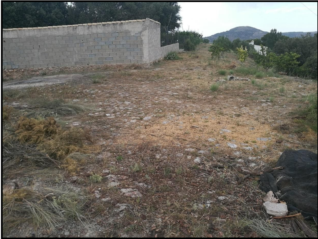
Detalle del estado actual de la era.
