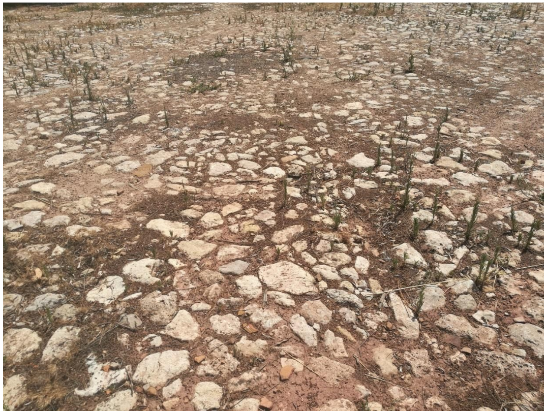
Detalle de la estructura en forma de estrella.
