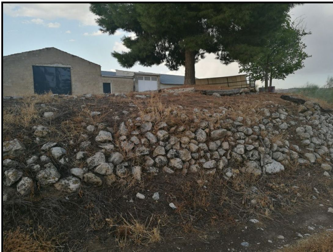
Vista del muro de mampostería de piedra seca que fija el talud Sur de la era.
