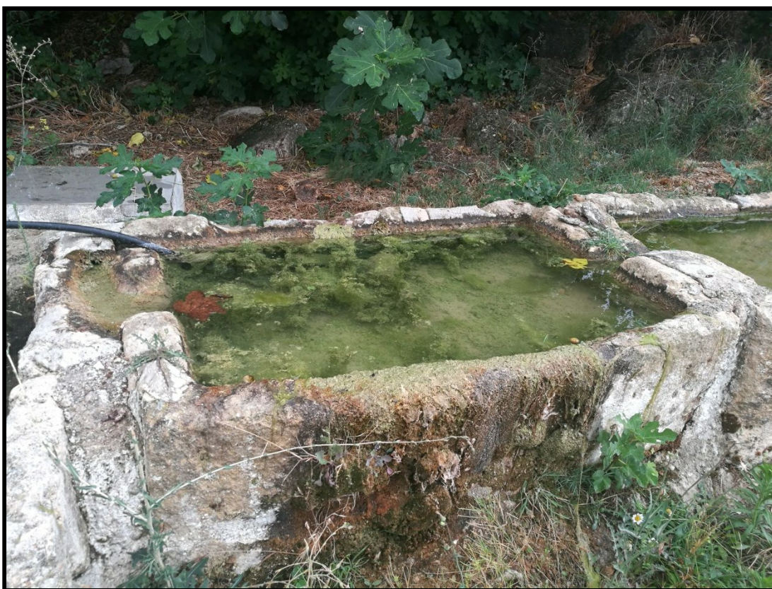
Vista de la Pila 2.
