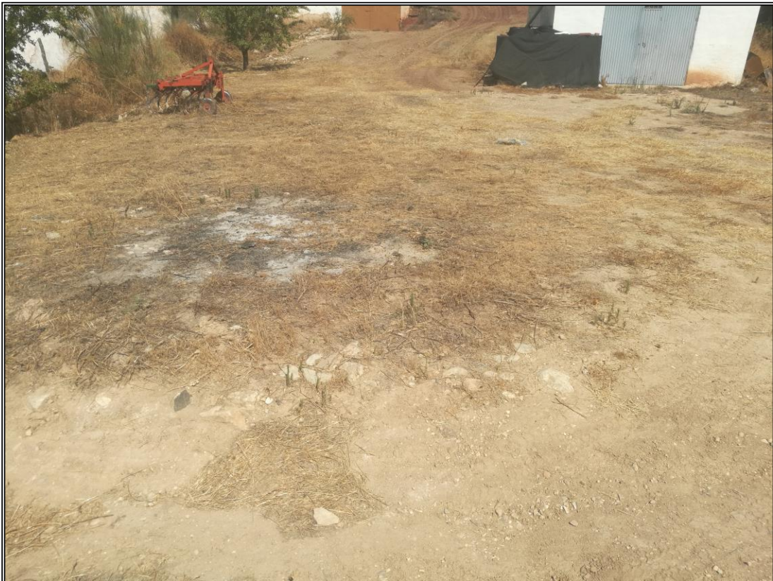
Era 2. Detalle del estado actual del empedrado, totalmente aterrado.
