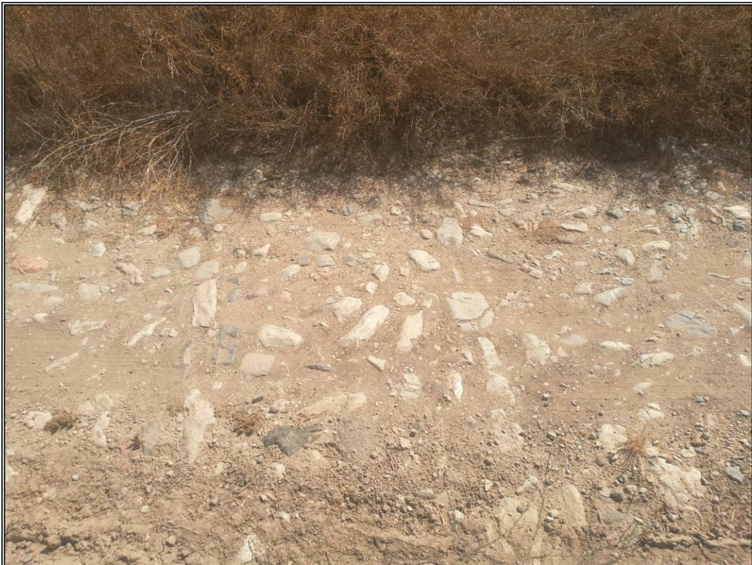
Era 2. Detalle del empedrado, se aprecia la estructura de piedras guía formando líneas paralelas.
