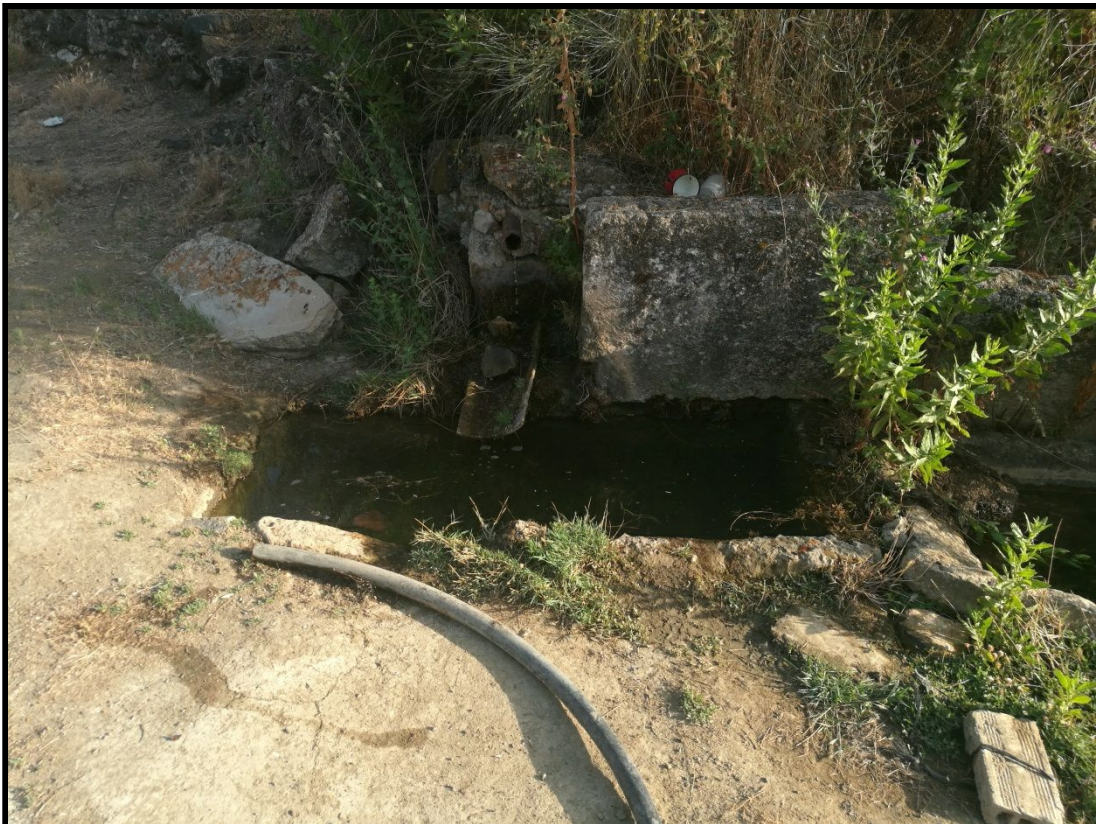
Vista del conjunto y de los bloques de piedra que fijan el talud Sur, se aprecia su deterioro con ligera inclinación de estos hacia las pilas por la presión del terreno.
