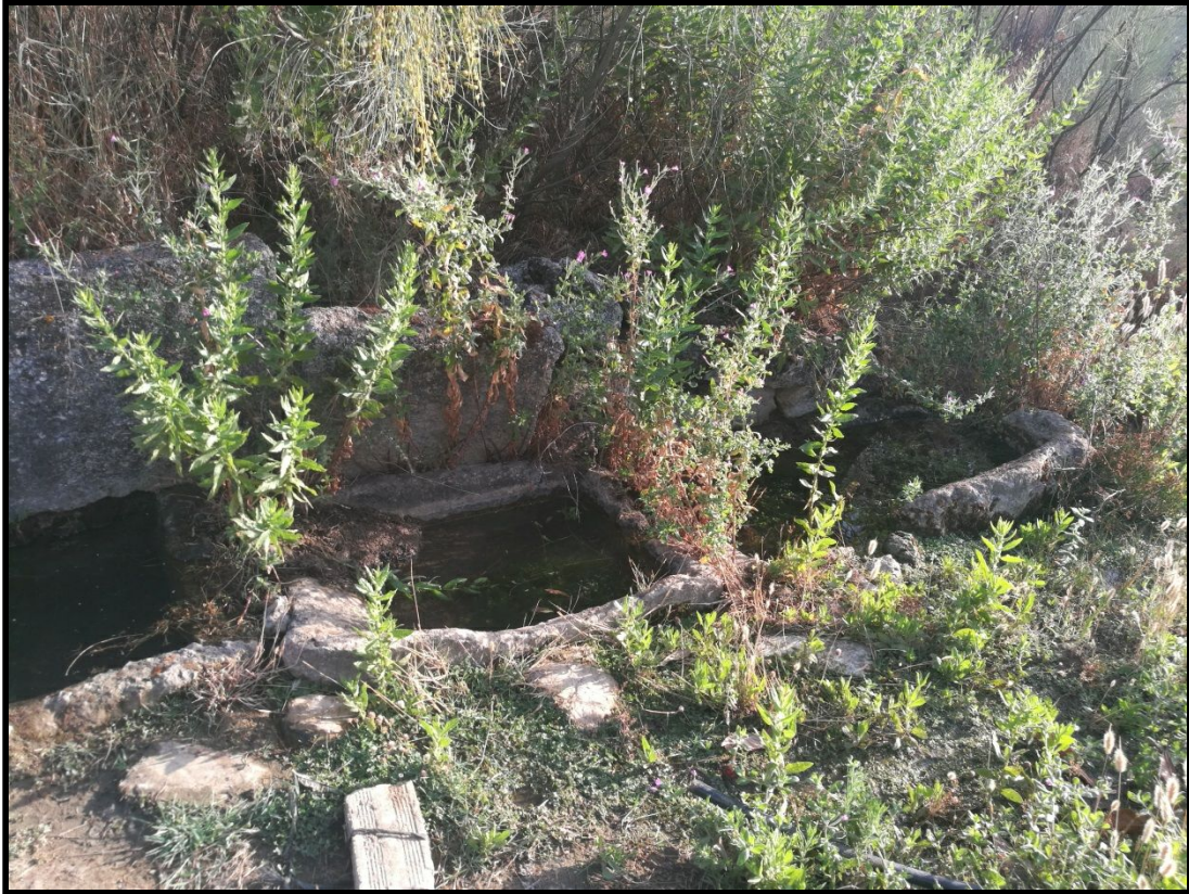
Vista del conjunto y de los bloques de piedra que fijan el talud Sur, se aprecia su deterioro con ligera inclinación de estos hacia las pilas por la presión del terreno.
