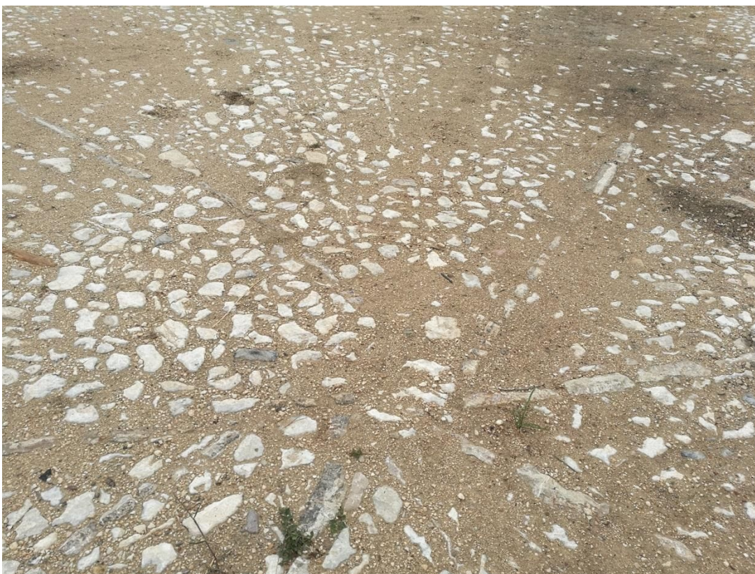
Era 1. Detalle del empedrado.
