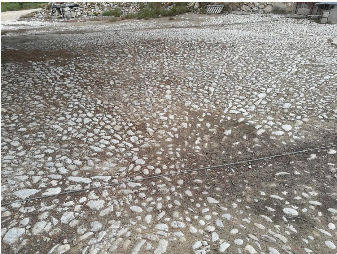
Era 2. Detalle del empedrado.
