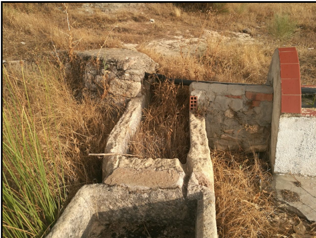
Detalle de la Pila 1.
