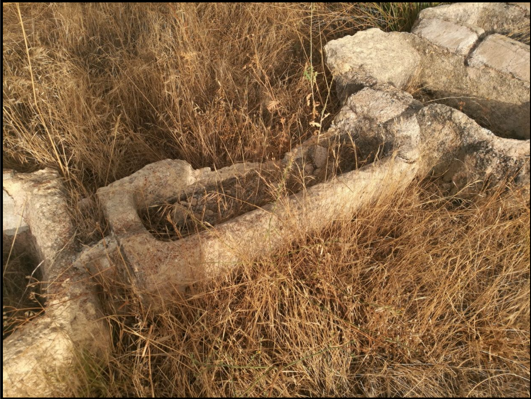
Vista de la Pila 4, se aprecia el estado de deterioro, con un lateral roto.
