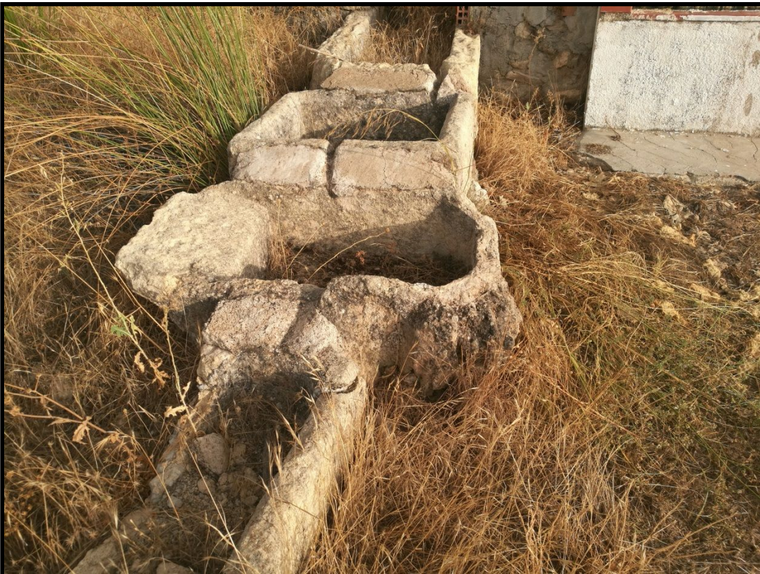
Vista de la Pila 3, pila de lavar.
