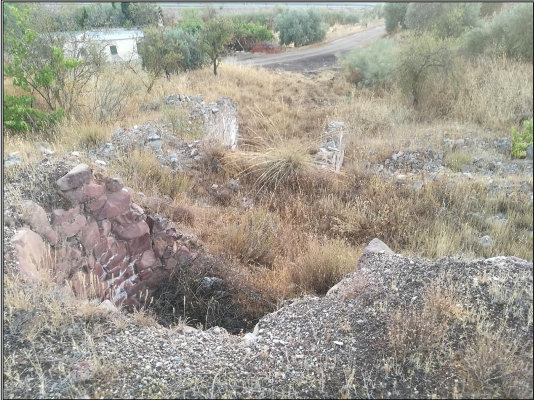
Vista panorámica de los hornos en relación a la yesera, ubicada en un plano inferior.
