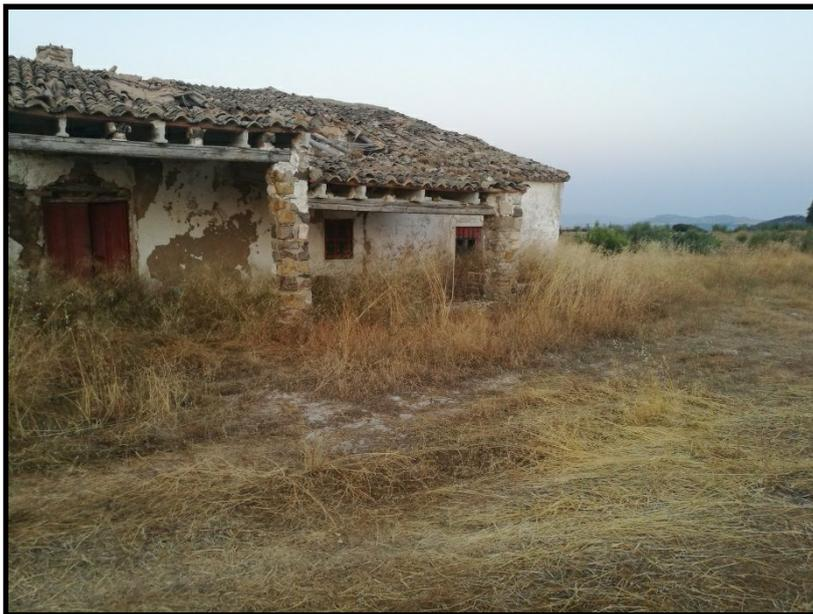
**Conservación:** Destruída en su lado Norte por la construcción de una zanja para enterrar una tubería. El resto bastante deteriorada, totalmente cubierta de tierra y hierba, que hacen casi imposible establecer los bordes reales del empedrado.
