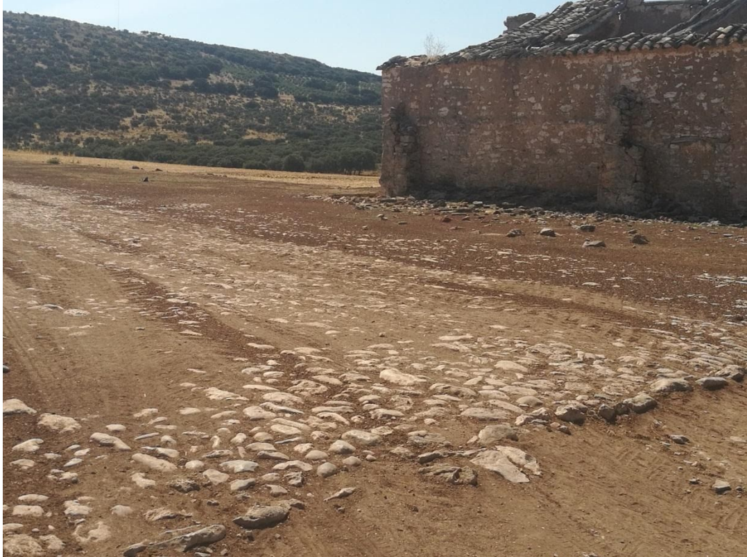
Vista parcial de la construcción. Detalle del empedrado realizado en los bordes.
