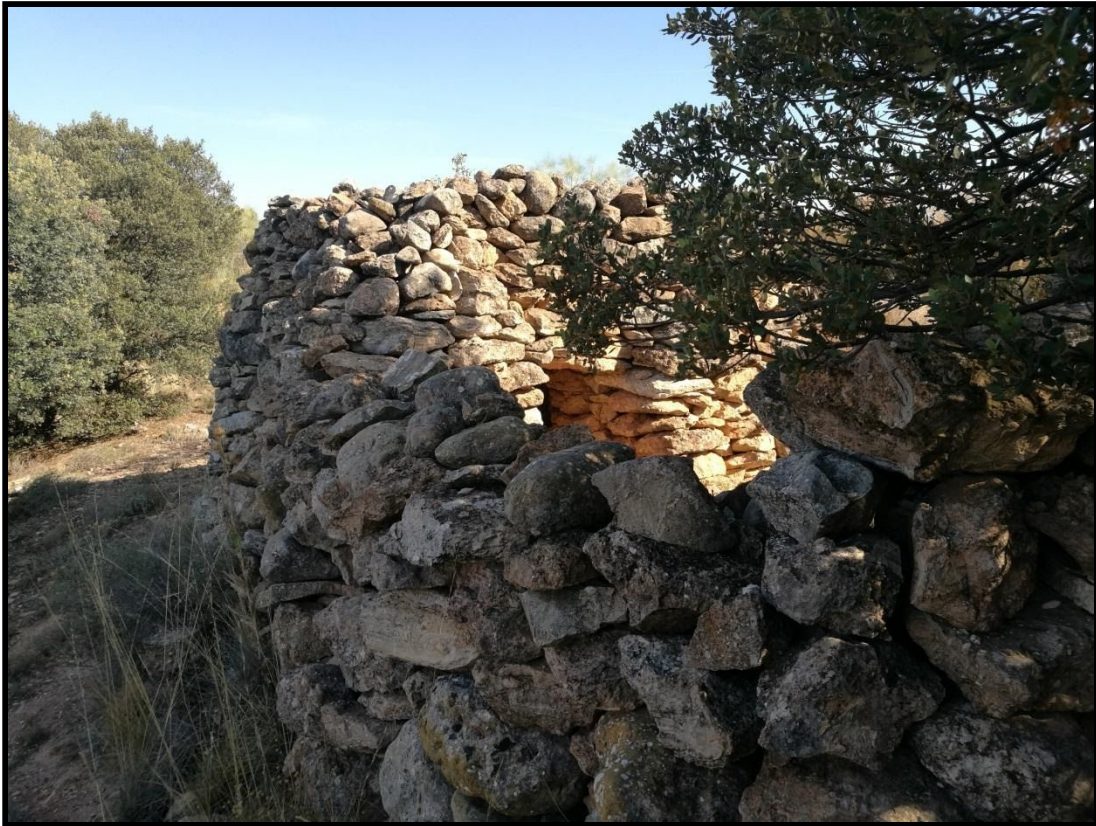
Detalle del muro que forma el cerramiento o patio.
