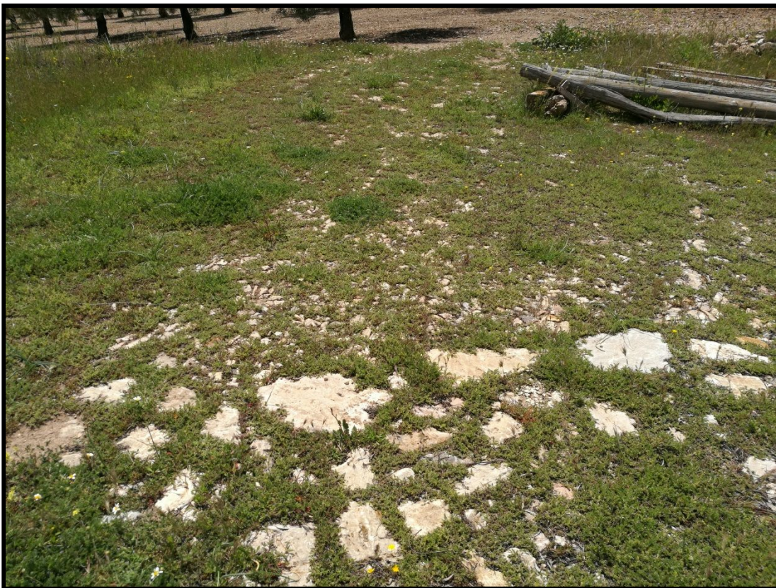
Vista de la zona Oeste de la construcción. Detalle del empedrado de la era original y la zona de ampliación con piedra de menor tamaño.
