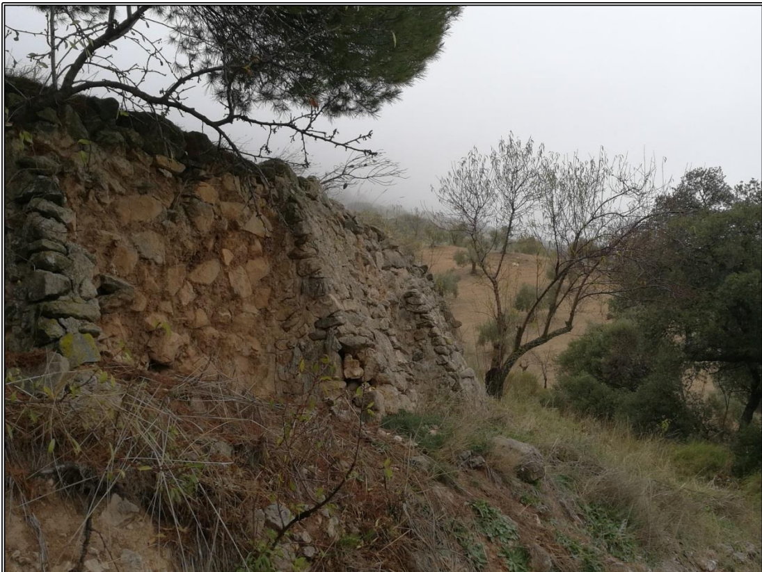
Detalle de los contrafuertes construidos para estabilizar la albarrada.
