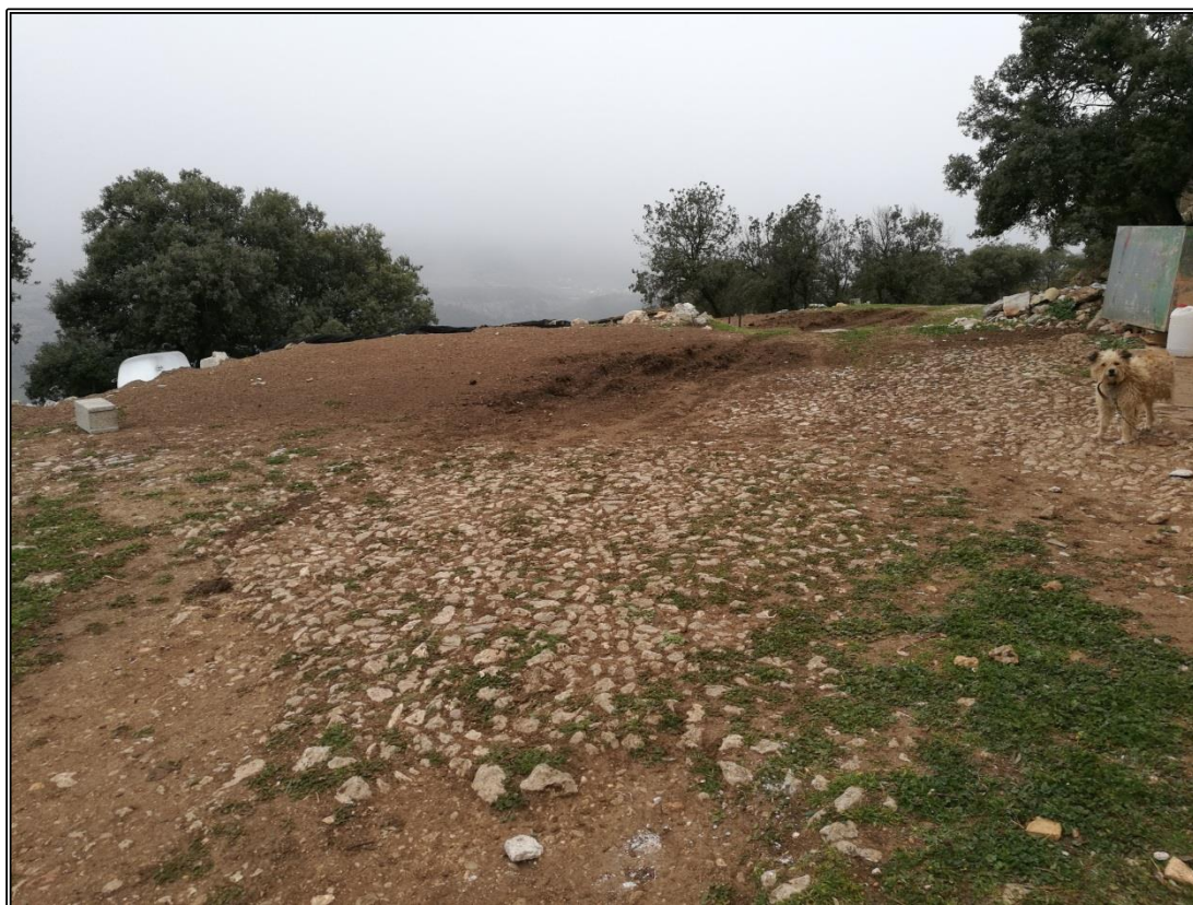
Detalle de la construcción en piedra seca.
