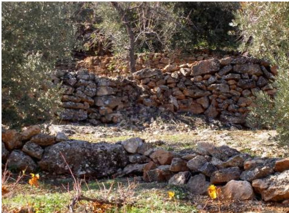
Muro de las Ventosillas
