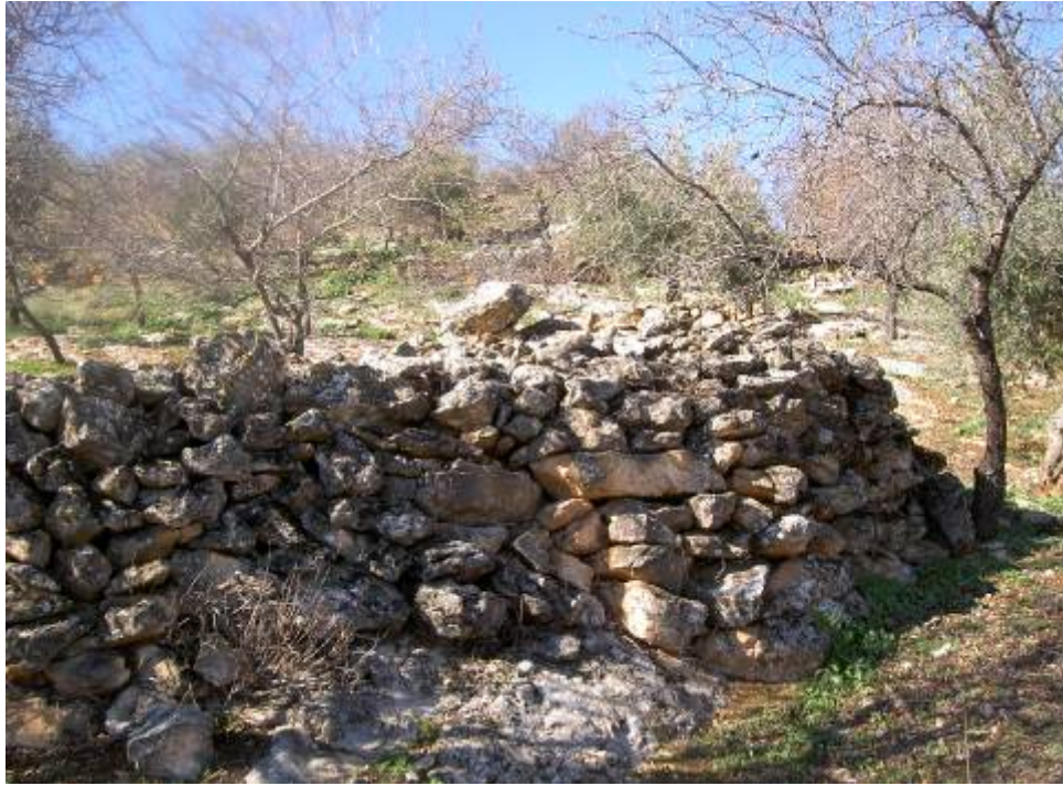
Muro en las Ventosillas
