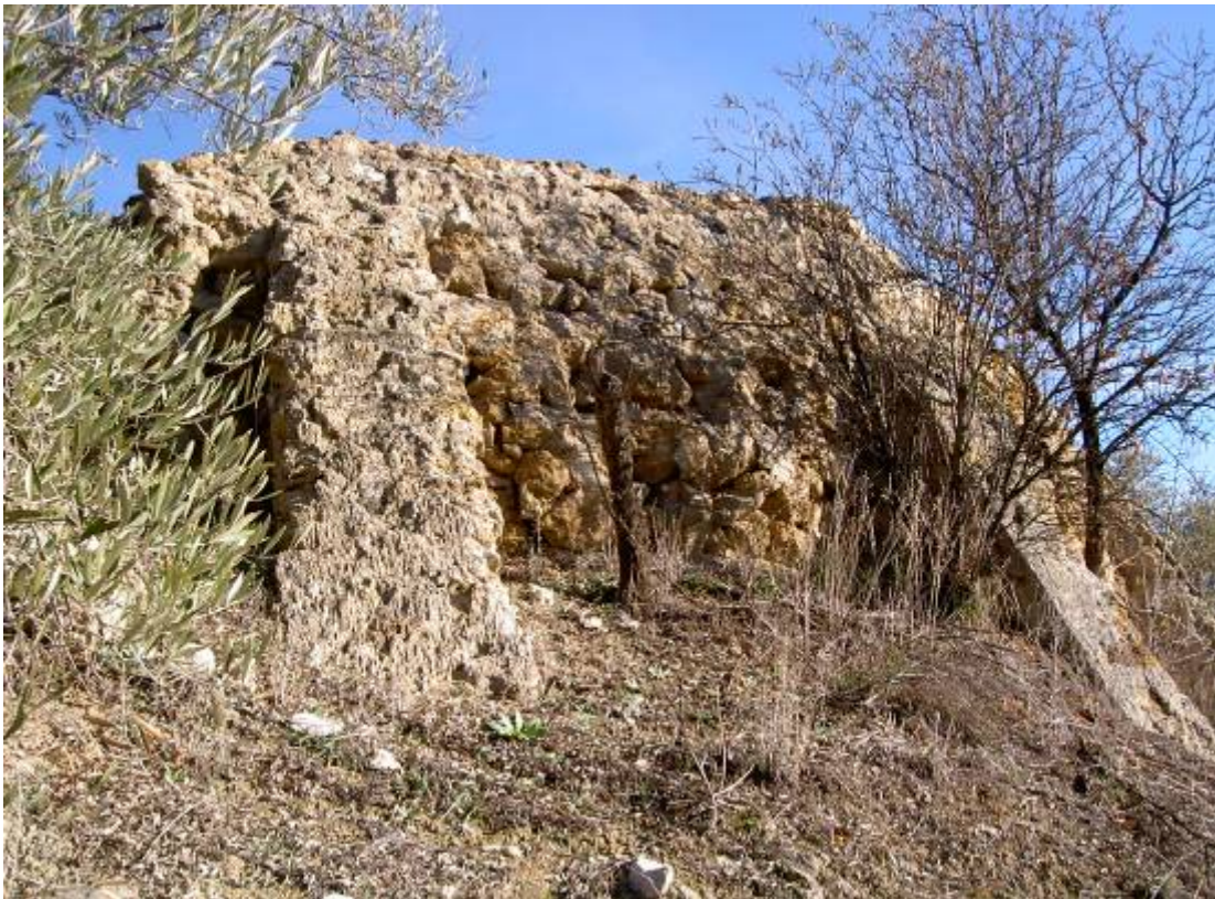
Contrafuertes de mampostería
