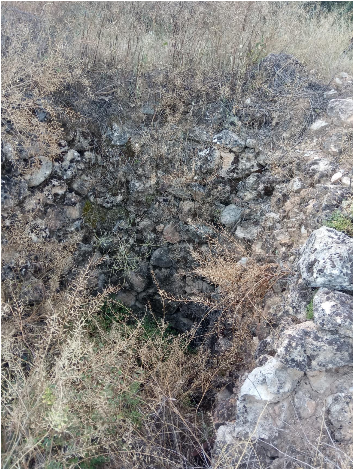
Fotografías: Pozo de evacuación de aguas 2 (04/06/2020)
