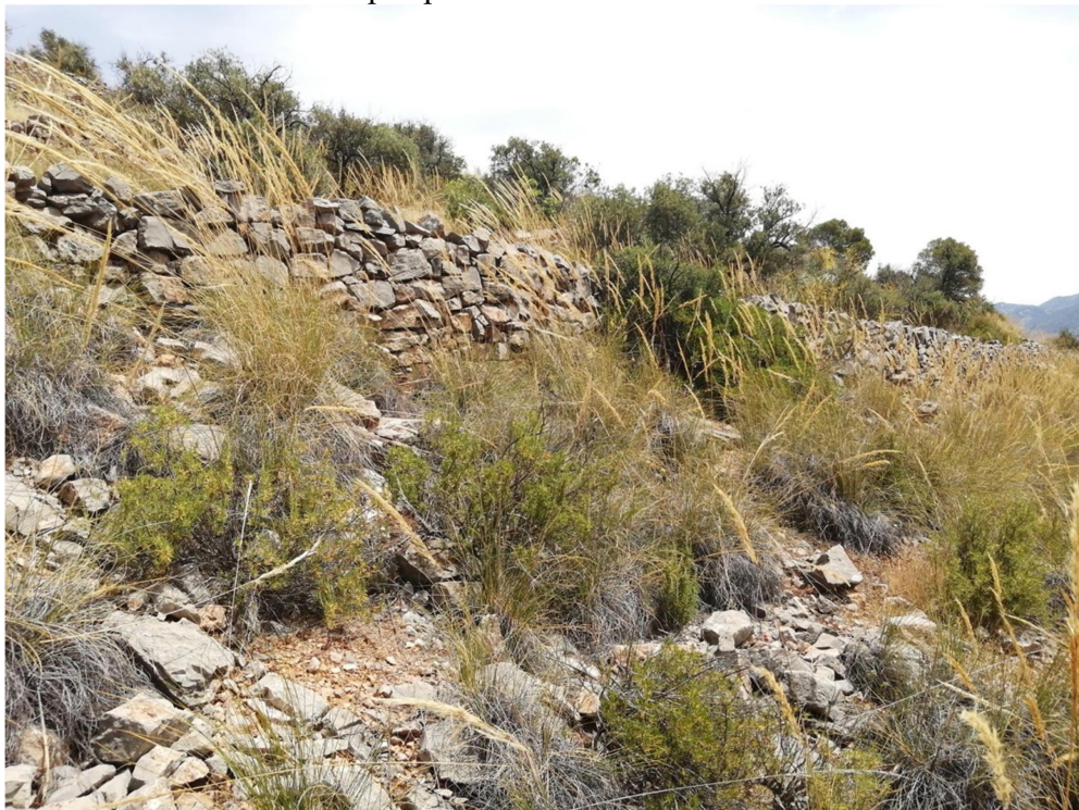
Vista parcial del muro de mayor longitud (76 metros) del polígono.
