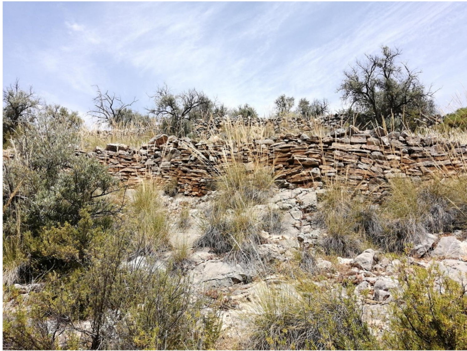
Muro realizado con lajas de piedras calizas.
