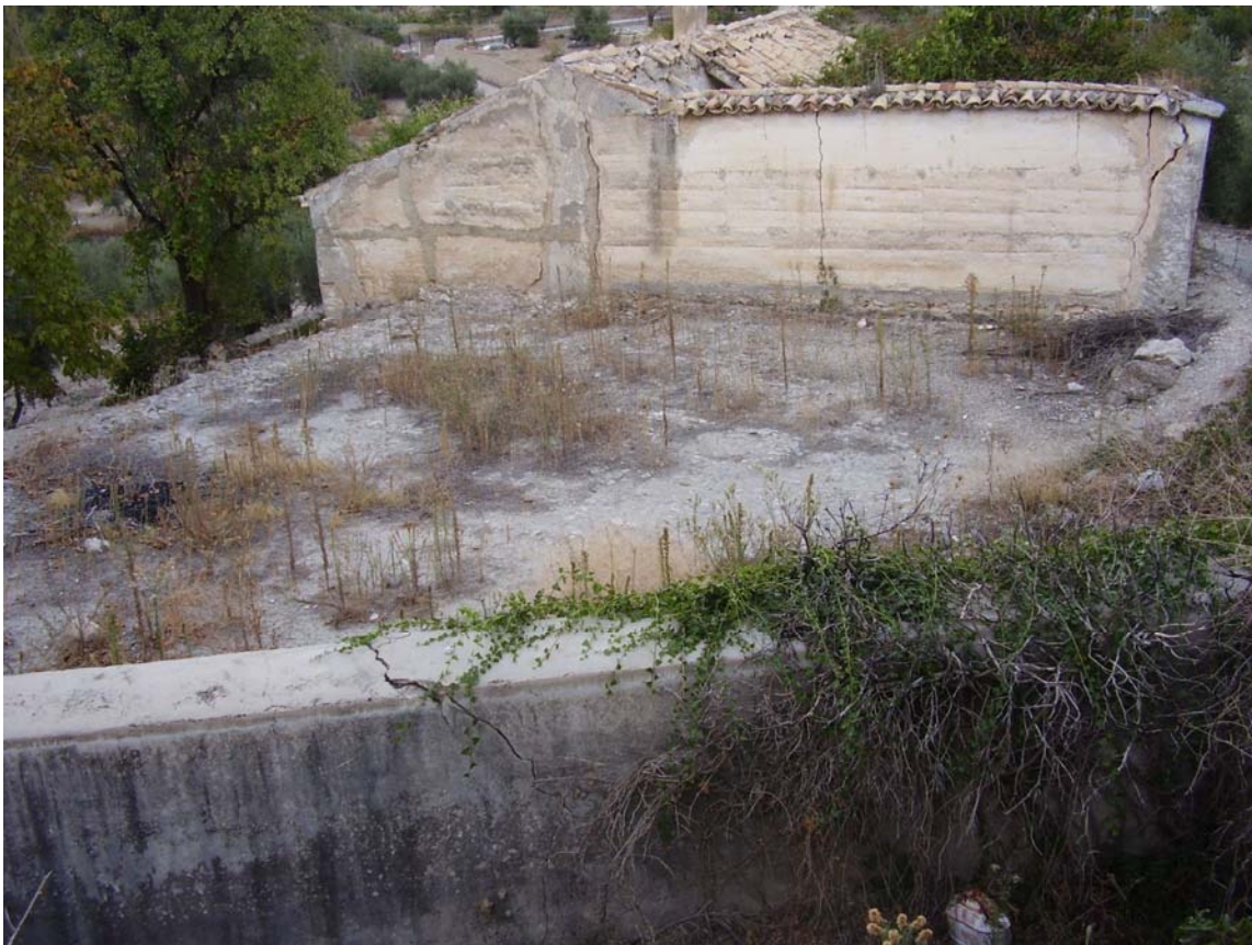
Foto 1. Vista general de la era y elementos anejos.
