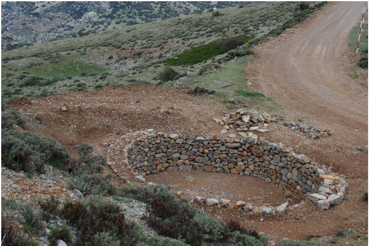
Pozo Almadén rehabilitado
