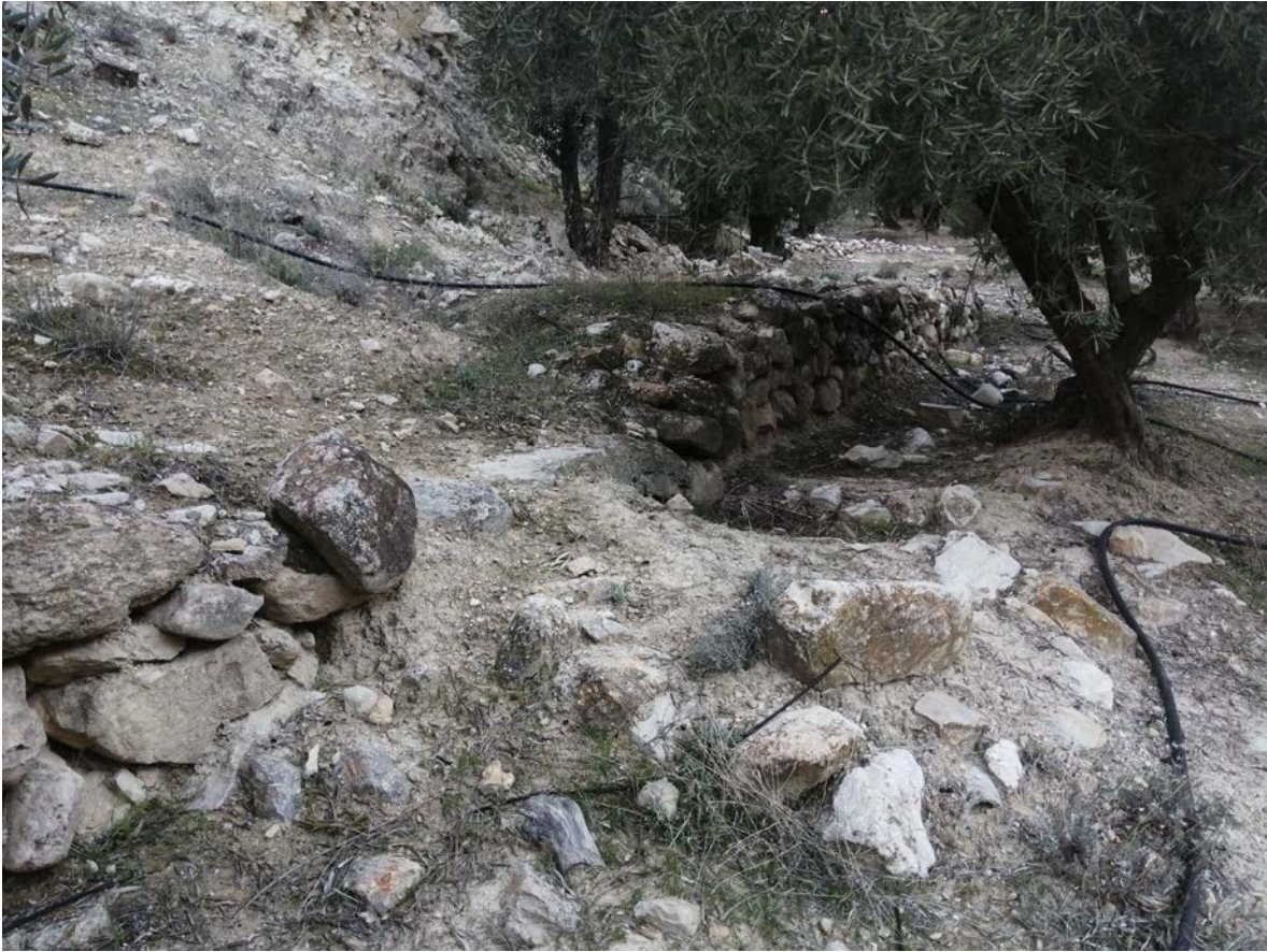
Albarradas junto a la acequia del Arroyo de Bercho – Collado del Zapatero
