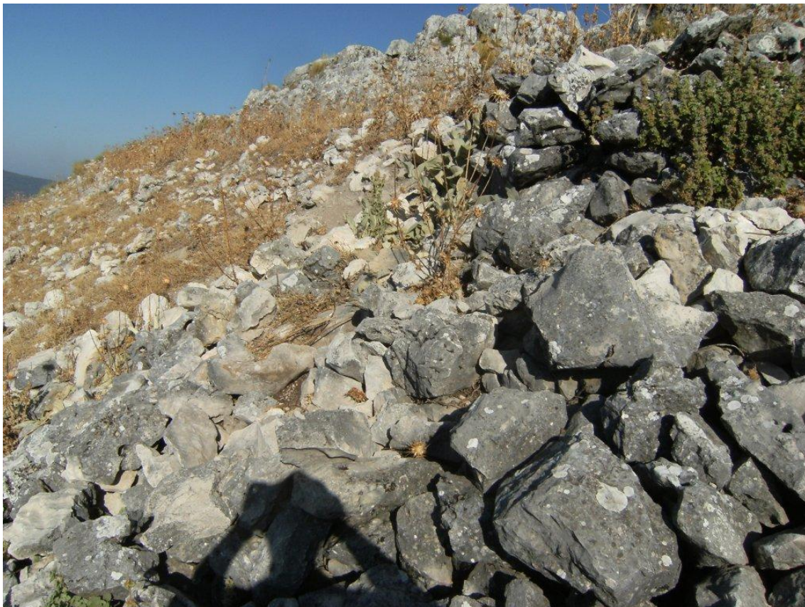
Restos de la alcazaba del castillo de Cerrillo Tesoro
